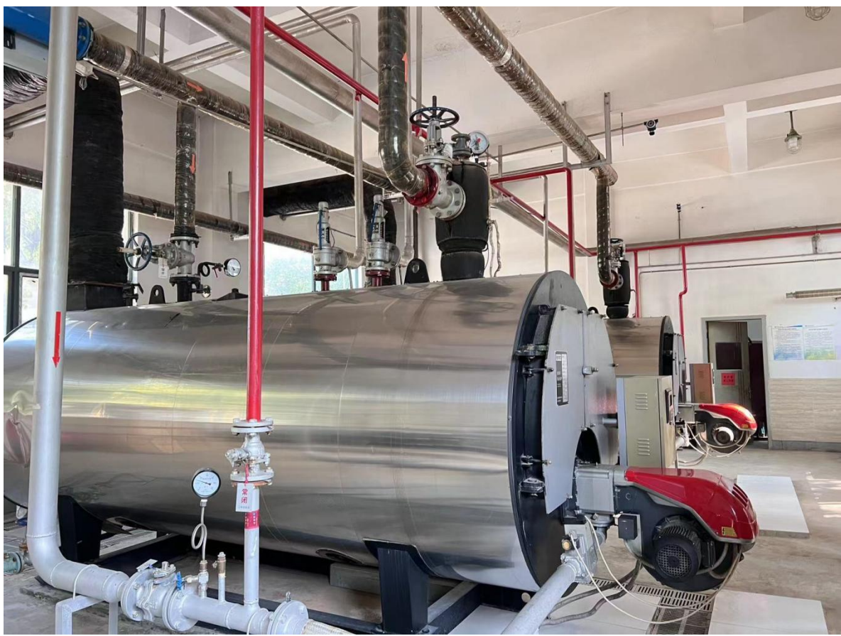
图 3-2 锅炉设备减振降噪措施图
